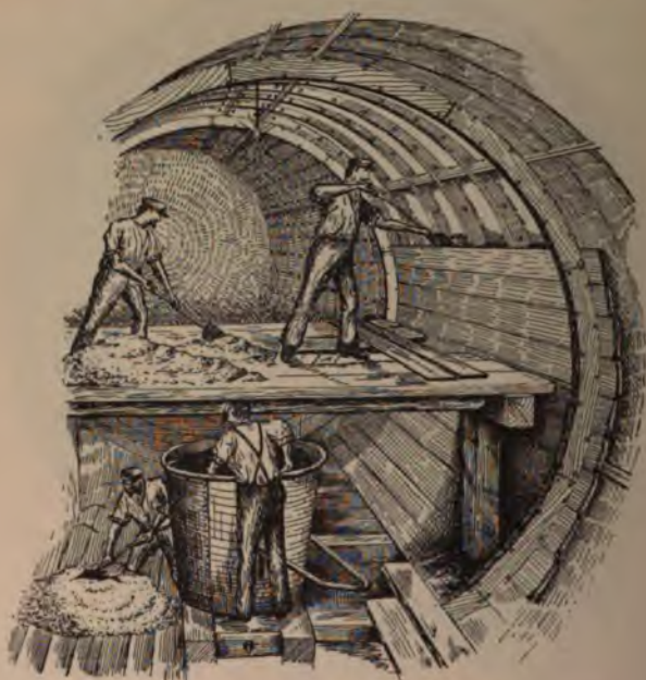
Fig. 276. — Exécution du revêtement en maçonnerie.
